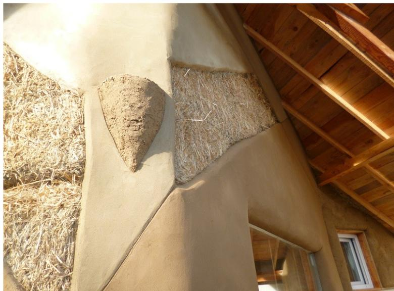
*Pignon avec paille apparente / vitre fixe dans enduit terre / applique lumineuse*
