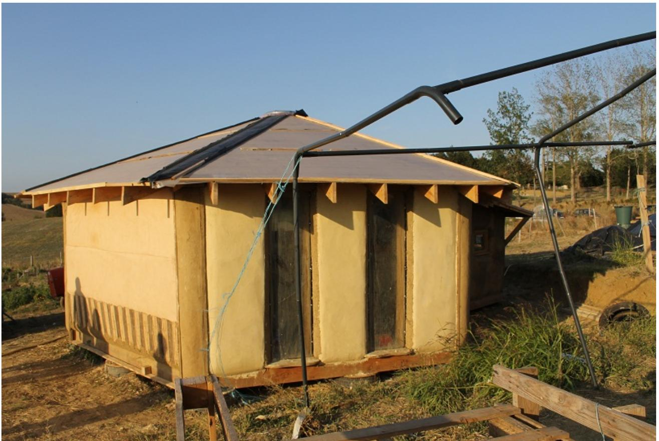
*Vitres fixes et protection partie basse du mur par osier collé dans la couche de corps*
