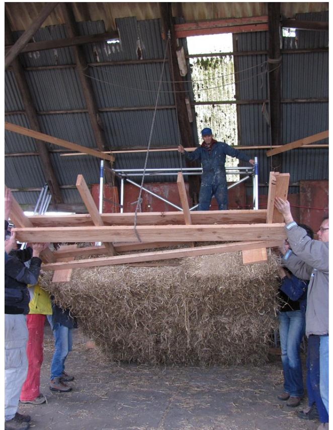
*Coucher le mur pour poser l'enduit plus facilement des 2 côtés*
